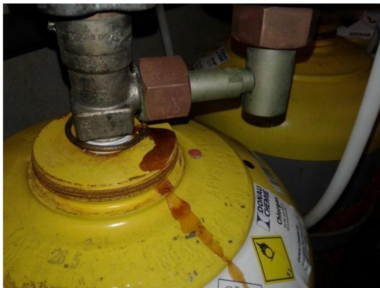
Bild 1 undichte Schraubverbindung
