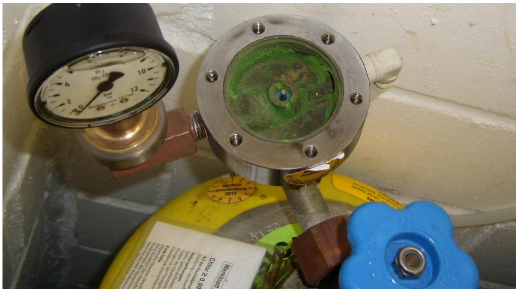
Bild 11 Chlorreaktionsprodukt mit Feuchtigkeit und Messing
